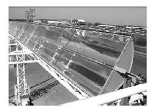
Considerando que a distância entre a borda inferior e a borda superior da superfície refletora tenha 6 m de largura e que focaliza no receptor os 800 watts/m² de radiação provenientes do Sol, e que o calor específico da água é 1 cal. g-1. °C-1 = 4.200 J. kg-1. °C-1, então o comprimento linear do refletor parabólico necessário para elevar a temperatura
